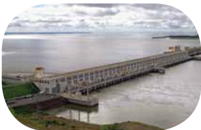
Central hidroeléctrica Yacretá
